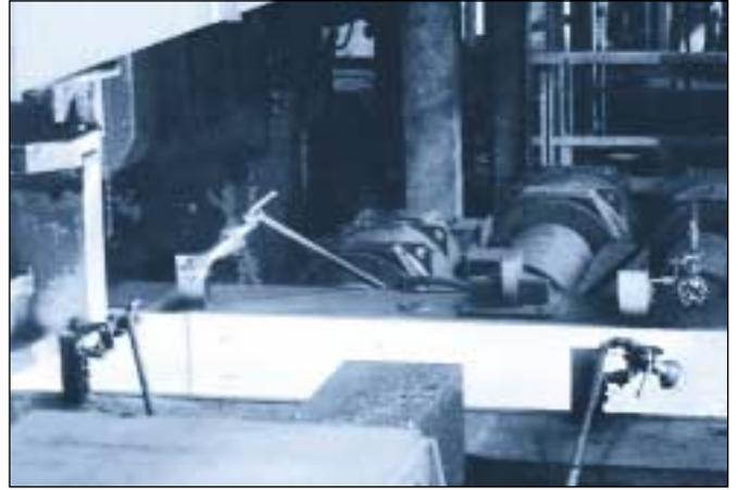
British Steel Corporation utilise en permanence les produits SILVENT. La photo ci-dessus montre l'utilisation de la torche SILVENT 1212 pour balayer les particules et l'eau de la surface de l'acier.
